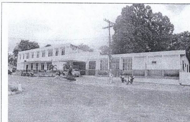
Foto 07: fachada do hospital apresenta boa aparência. Necessitado apenas de alguns reparos na pintura.
