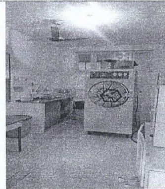
Foto 06: Sala de esterilização. Revisão de piso cerâmico, de pontos elétricos.
