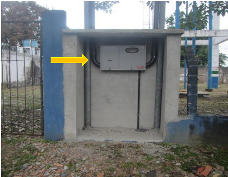
Foto 3: Mureta de alvenaria com cobertura de laje em concreto. Caixa de de Medição em Baixa Tensão para Transformador já existente, porém vai ser executada outra mureta para atender a necessidade de caixa de medição do transformador de 112,k KVA.
