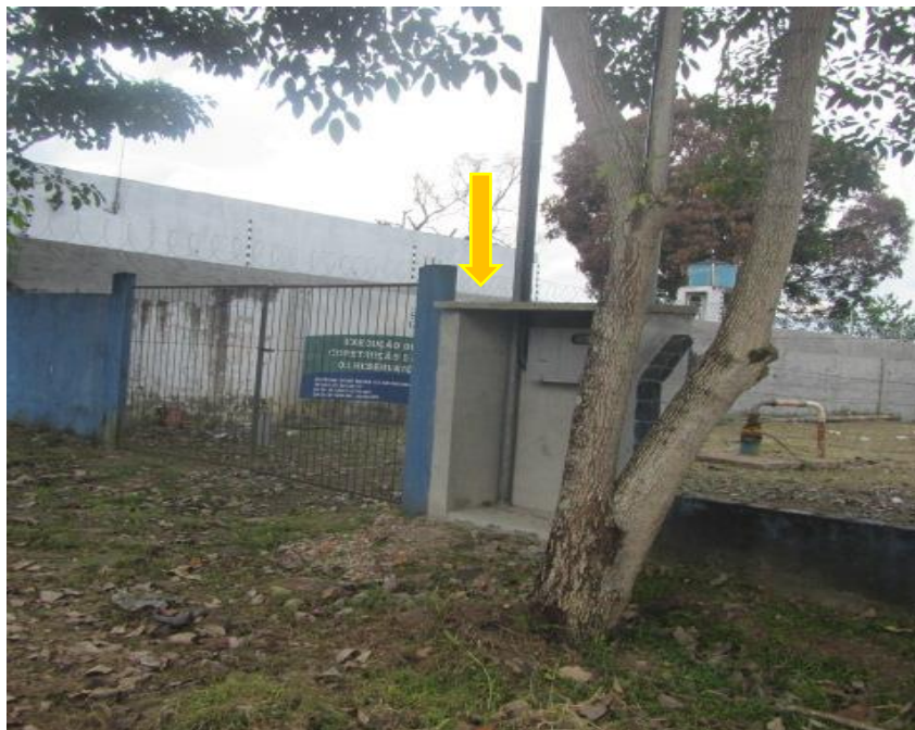
Foto 2: Vista da área de intervenção pela Av. Francisco Amâncio(frente), entrada do sistema de água. Mureta de alvenaria com cobertura de laje em concreto.
