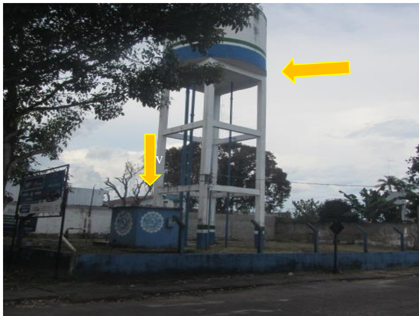
Foto 4: Vista pelo cruzamento da Av. Francisco Amâncio(frente) e Travessa Santa Izabel(pela lateral). Castelo D'água de 100m 3 e abaixo em azul, casa de bomba e energia.
