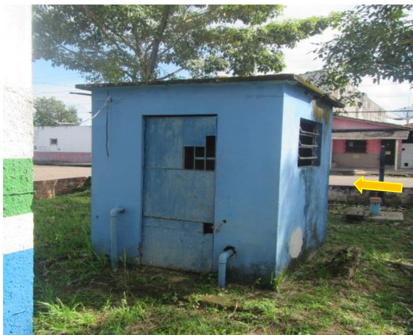
Foto 6: : Vista de dentro do terreno do sistema de água. Castelo D'água de 100m 3 e abaixo em azul, casa de bomba e energia.
