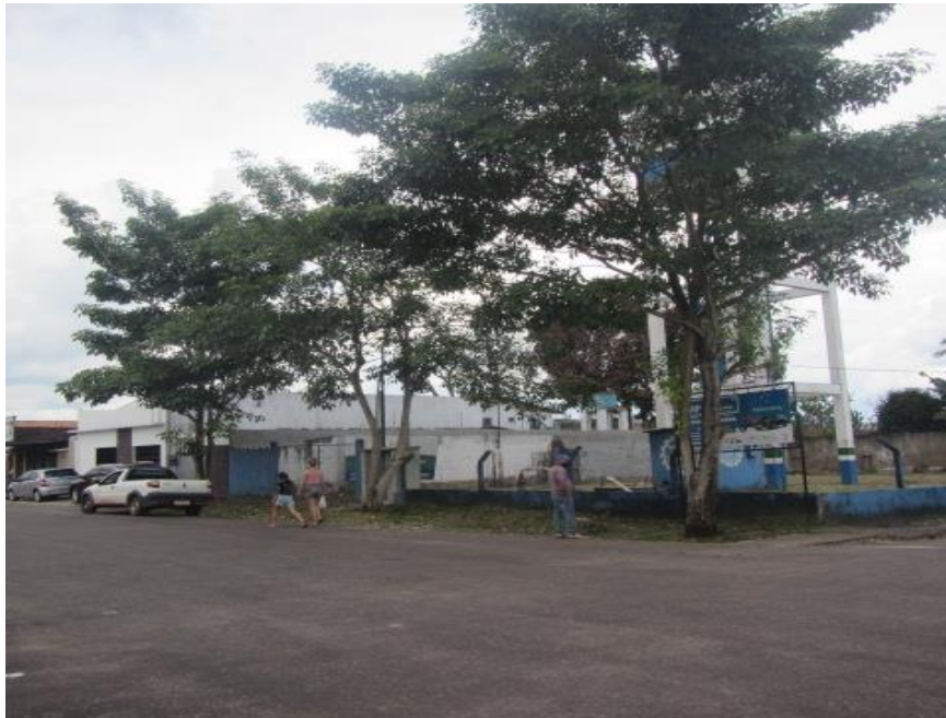
Foto 1: Vista da área de intervenção pela Av. Francisco Amâncio(frente)
