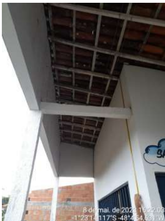
Foto 22 e 23: Vista interna da cobertura, evidenciando a parte que cedeu.
