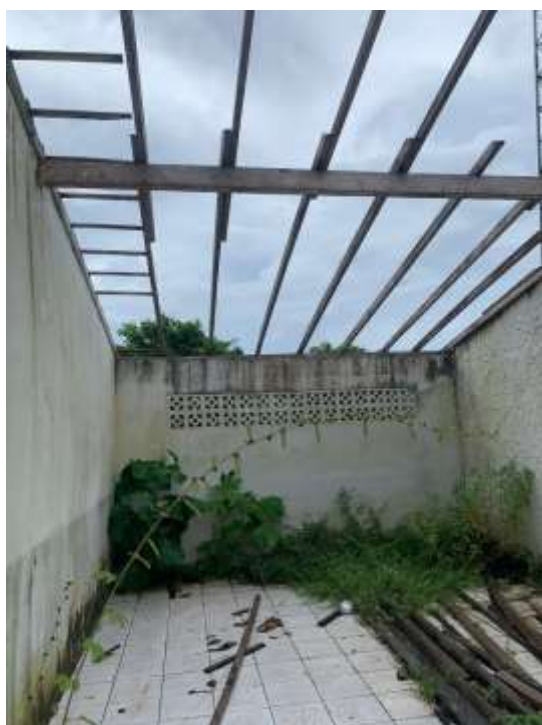
Foto 24 e 25: Vista interna, evidenciando uma sala com mato e sem telhamento.
