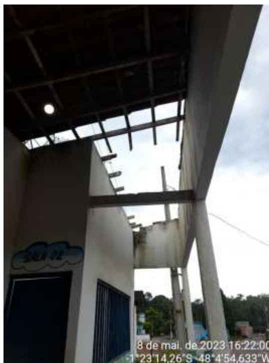
Foto 22 e 23: Vista interna da cobertura, evidenciando a parte que cedeu.
