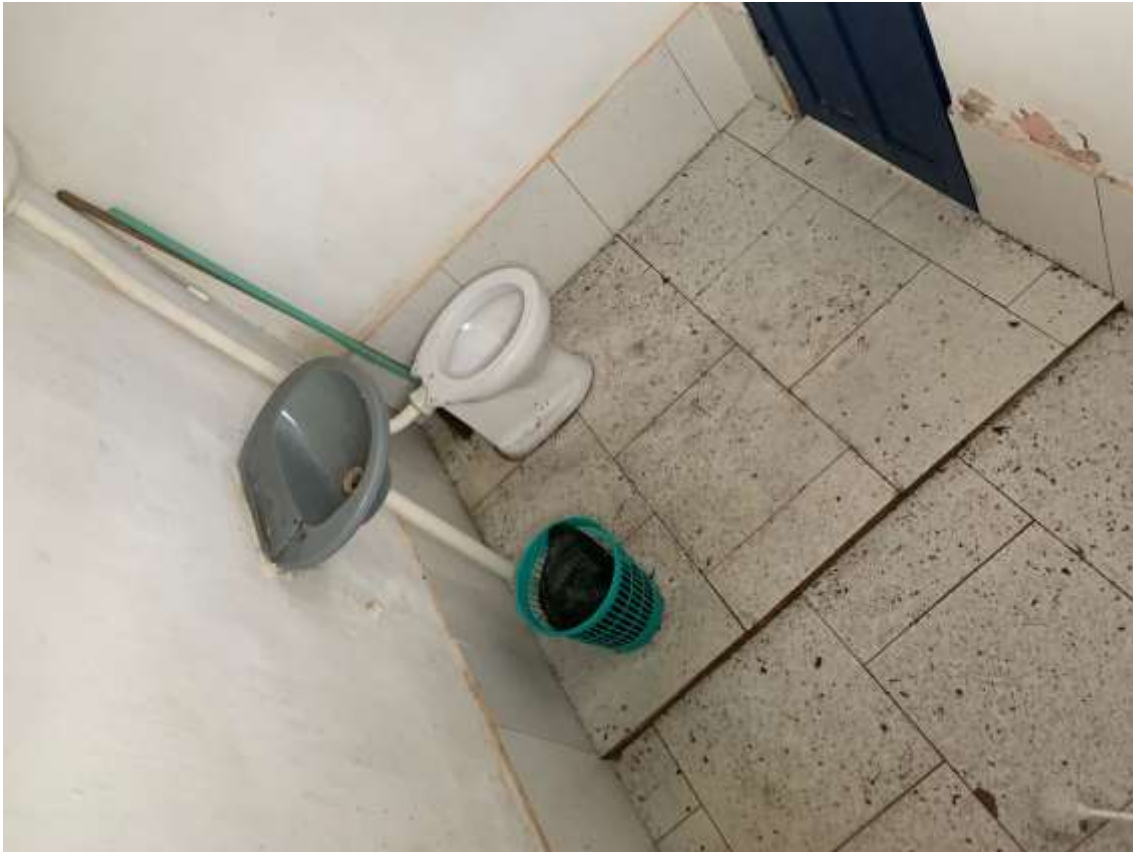
Foto 30: Vista do banheiro interno.
