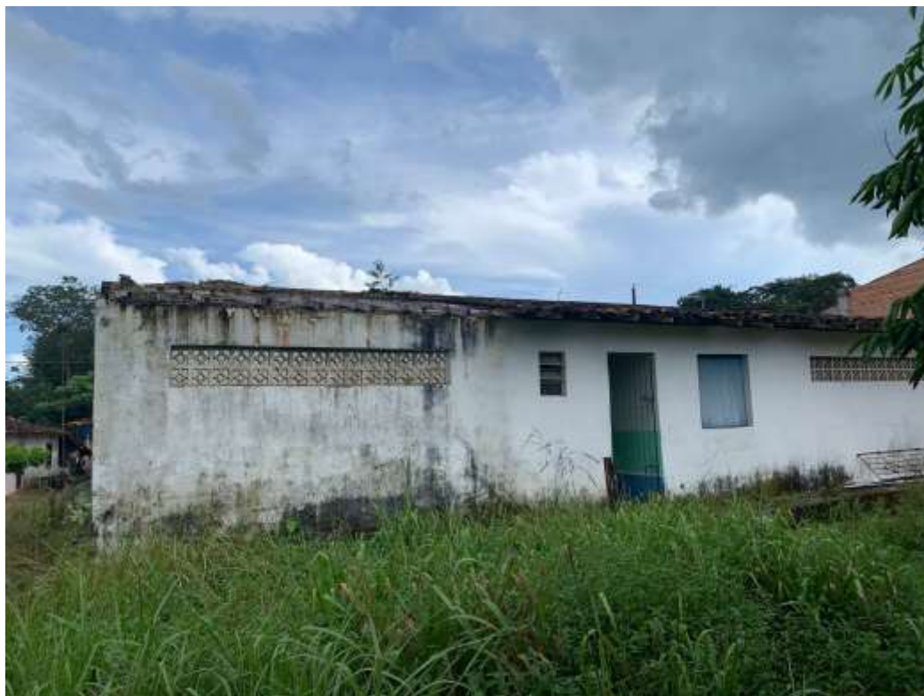
Foto 11: Vista da fachada posterior da escola.
