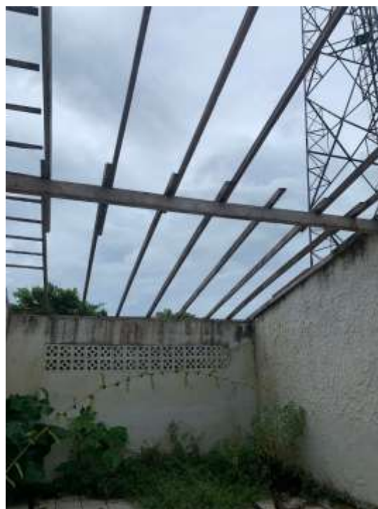
Foto 24 e 25: Vista interna, evidenciando uma sala com mato e sem telhamento.
