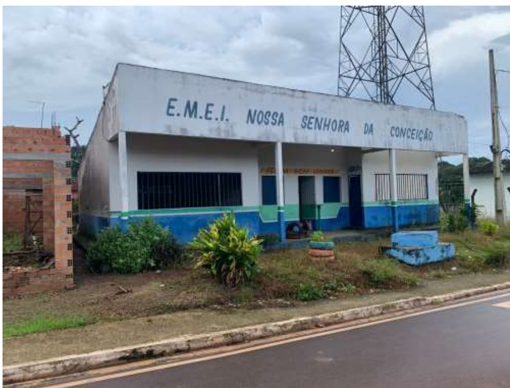
Foto 02: Vista da fachada principal e fachada lateral direita, aos fundos a torre de transmissão de energia elétrica.
